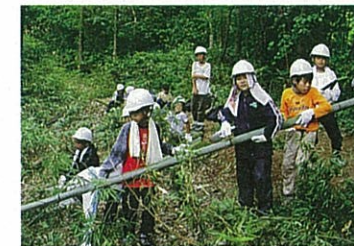
モウソウチクの除伐作業
