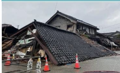
家屋倒壊（珠州市三崎町地内）
