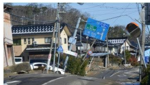
液状化（内灘町西荒屋地内）
