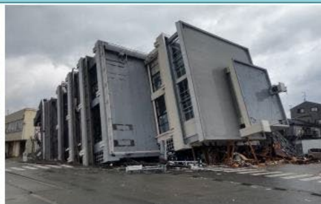
建物倒壊（輪島市河井町地内）
