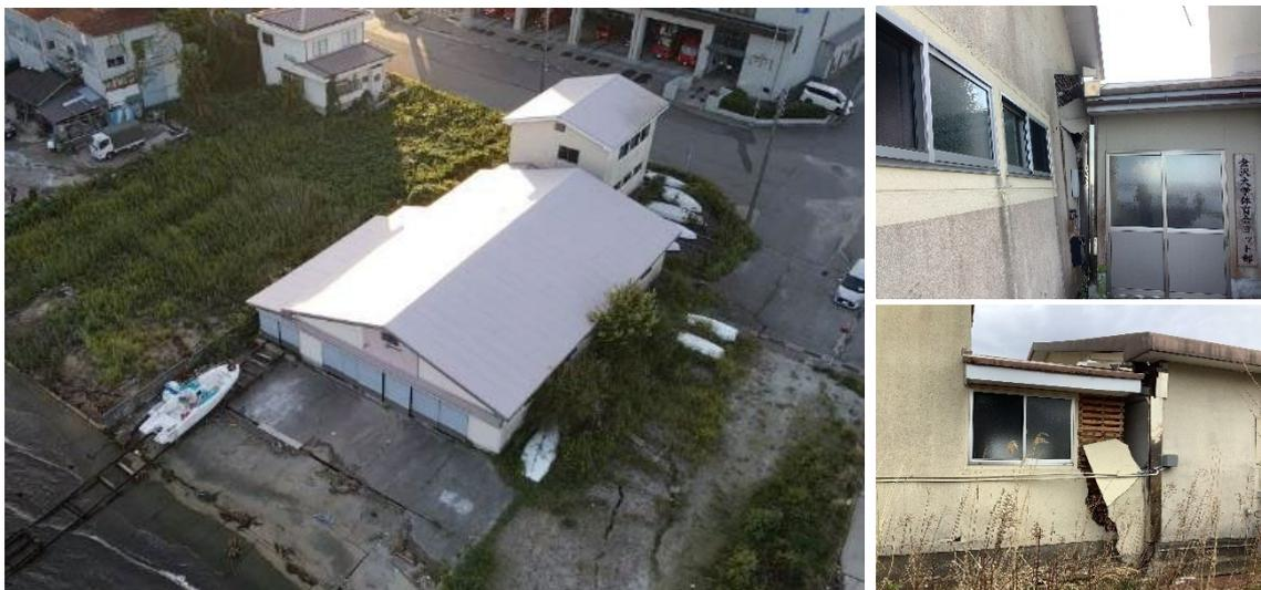
図 2-6-4：ヨット艇庫の被害状況（左：空撮写真、右上：建物傾き状況（艇庫）、右下：外壁損傷状況（合宿施設））
