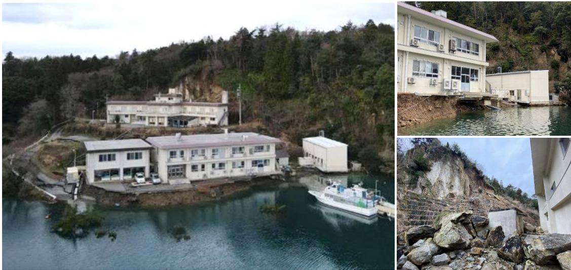
図 2-6-2：臨海実験施設の被害状況（左：空撮写真、右上：崩壊した護岸、右下：がけ崩れ状況）
