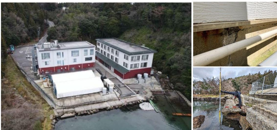
図 2-6-3：能登海洋水産センターの被害状況（左：空撮写真、右上：研究宿舎棟基礎周りのクラック、右下：被災した護岸）
