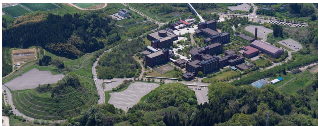
構内幹線道路沿いに設けた駐車場・駐輪場（角間北地区）
