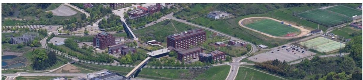
角間中地区航空写真
