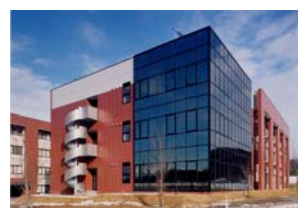
インキュベーション施設
